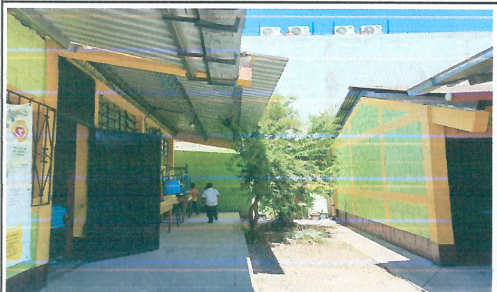
Foto 3: Mejoramiento de techo tipo pórtico
